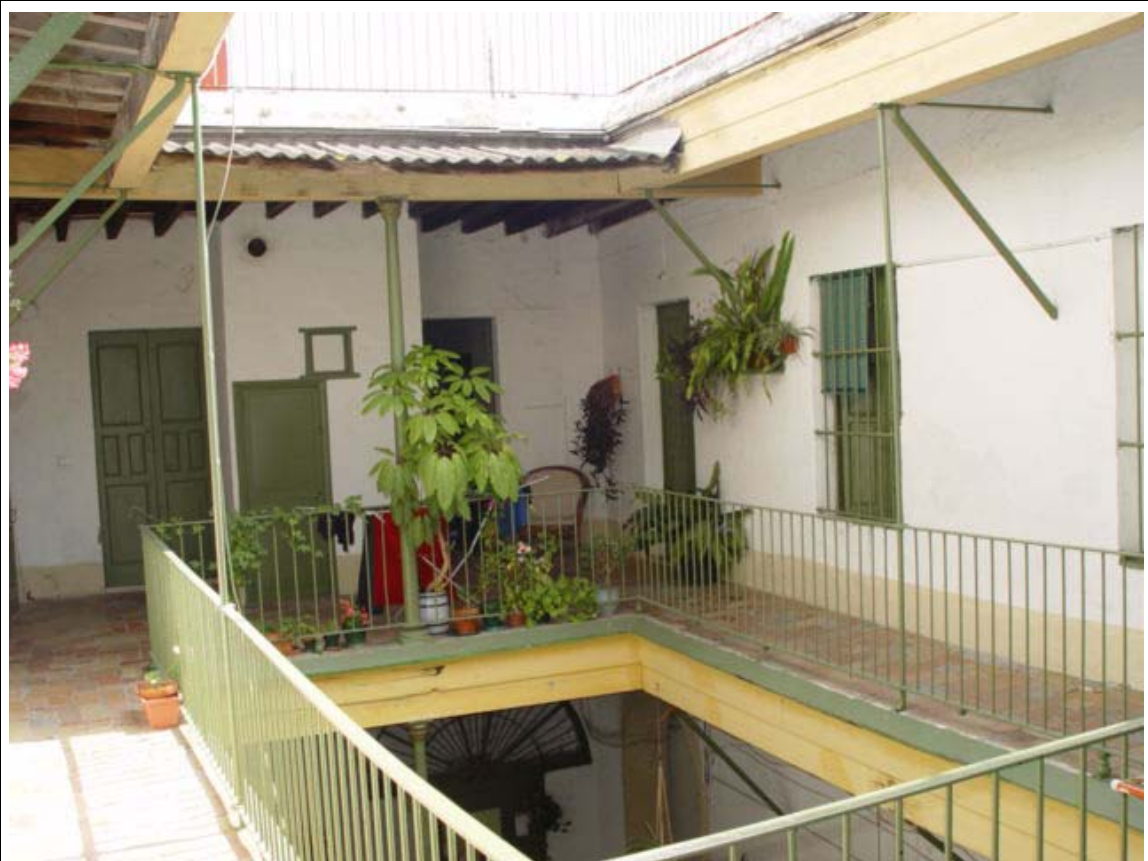
Foto 6. Vista de Patio Principal.
