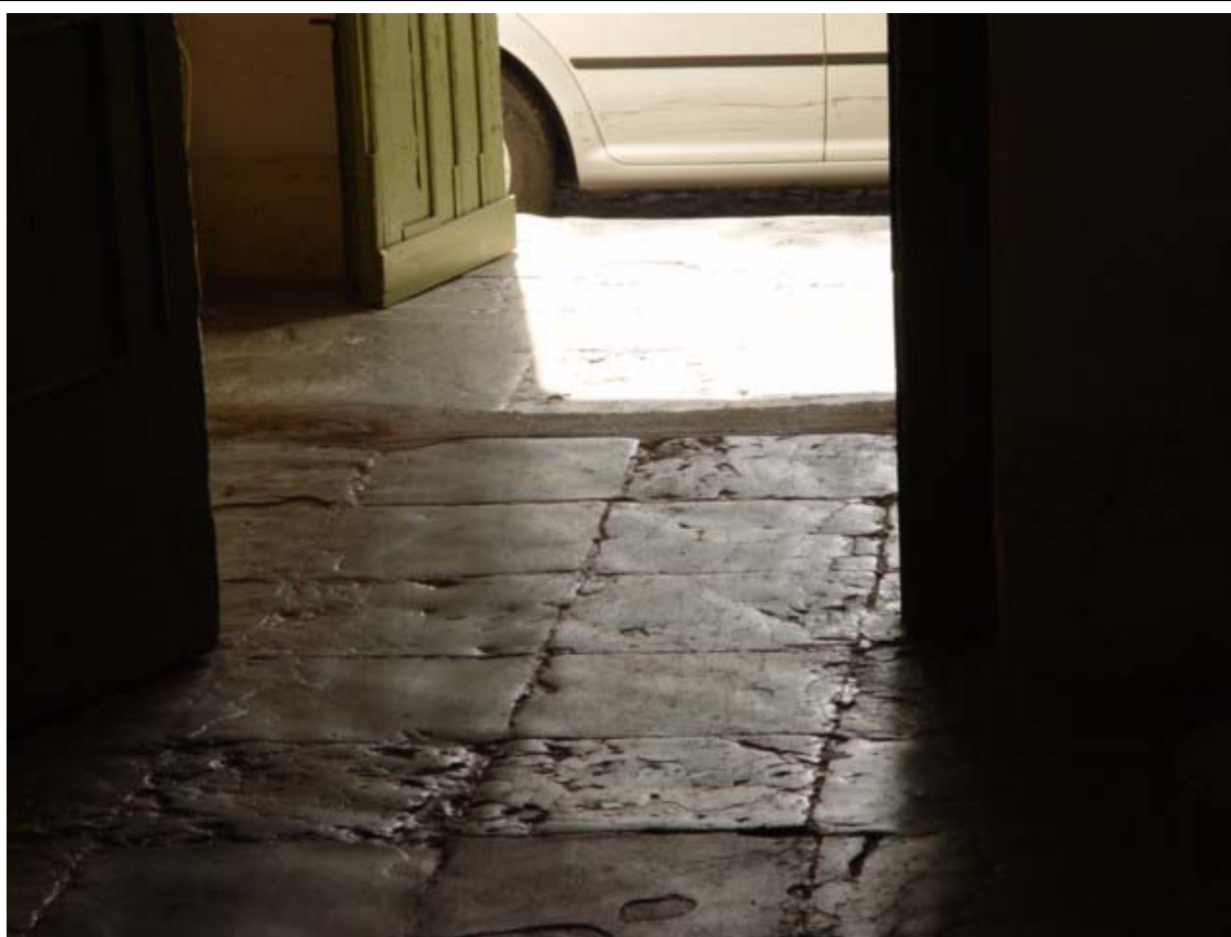
Foto 10. Vista de Portal.
