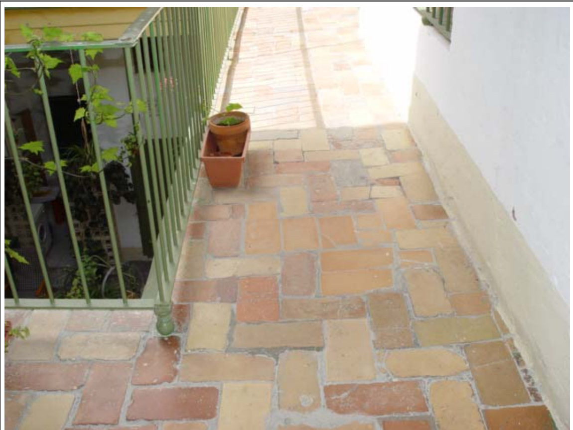
Foto 23. Suelos de galerías.
