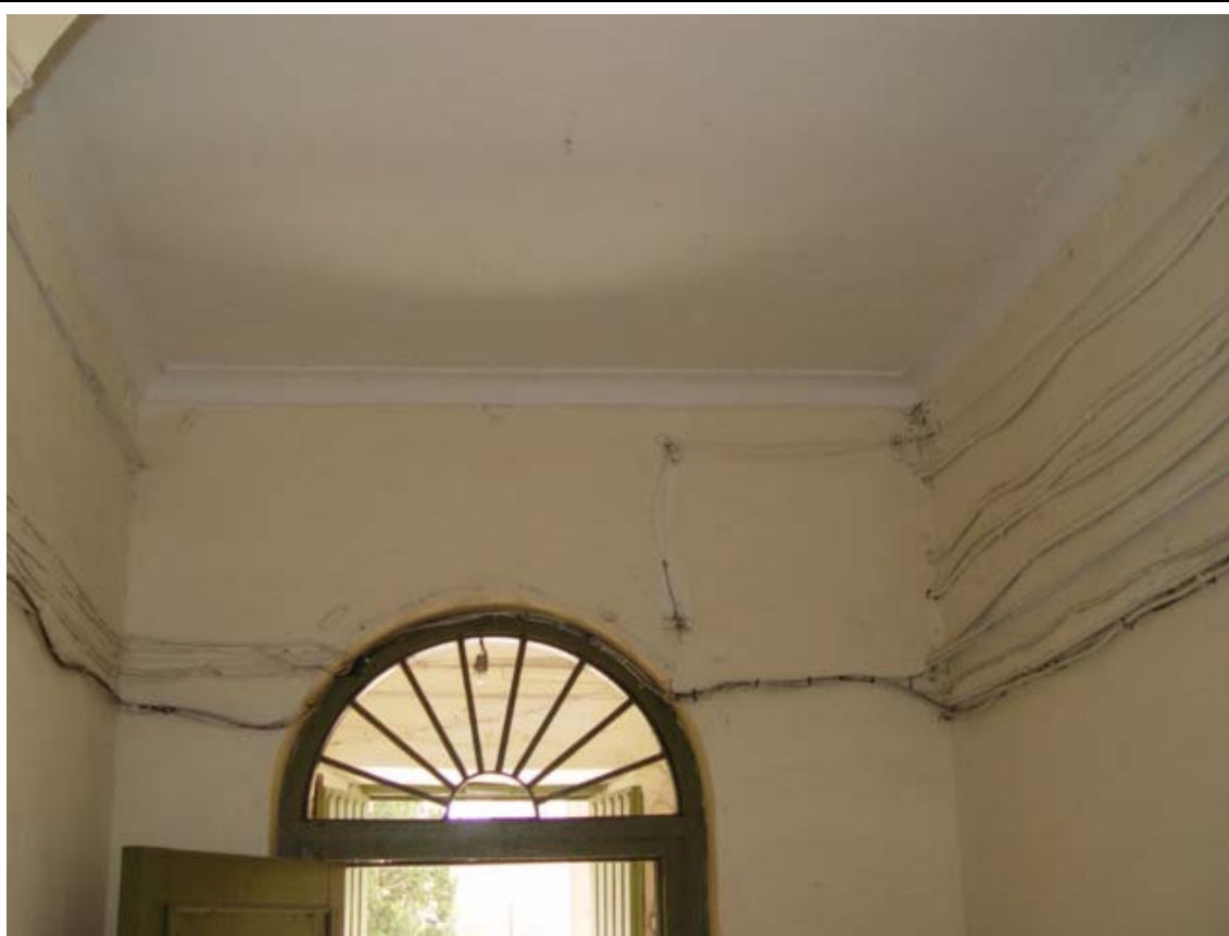
Foto 9. Vista de Portal.
