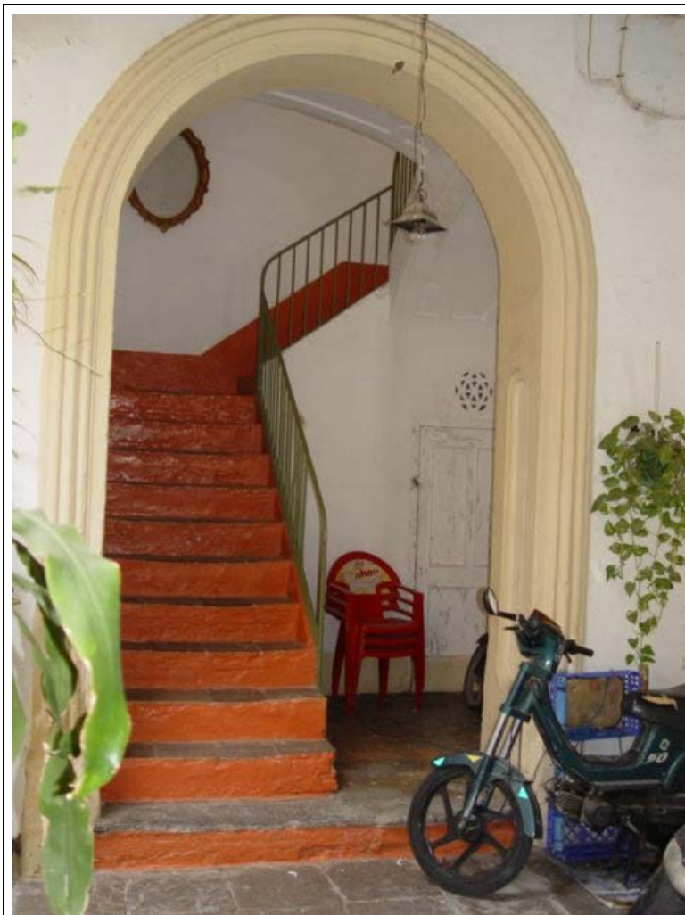
Foto 11. Vista de acceso a escaleras. Vehículos con combustible aparcados.
