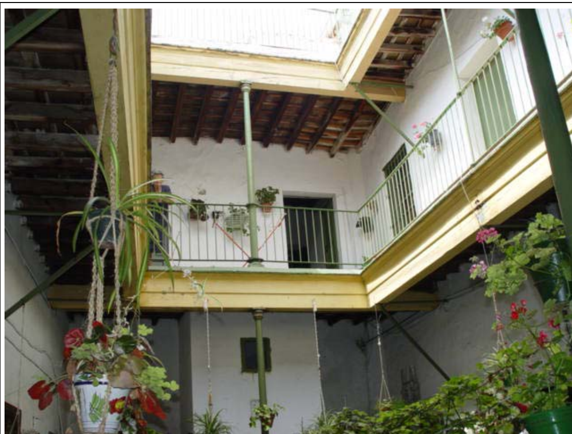
Foto 4. Vista de Patio Principal.
