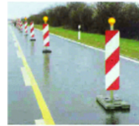
Luces amarillas fijas o intermitentes
